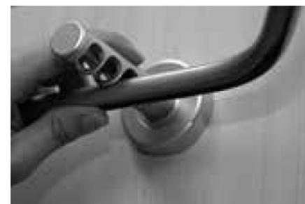
Bei gebogenen Anlagen muss die Schiene von unten in den Träger eingeklickt werden!
